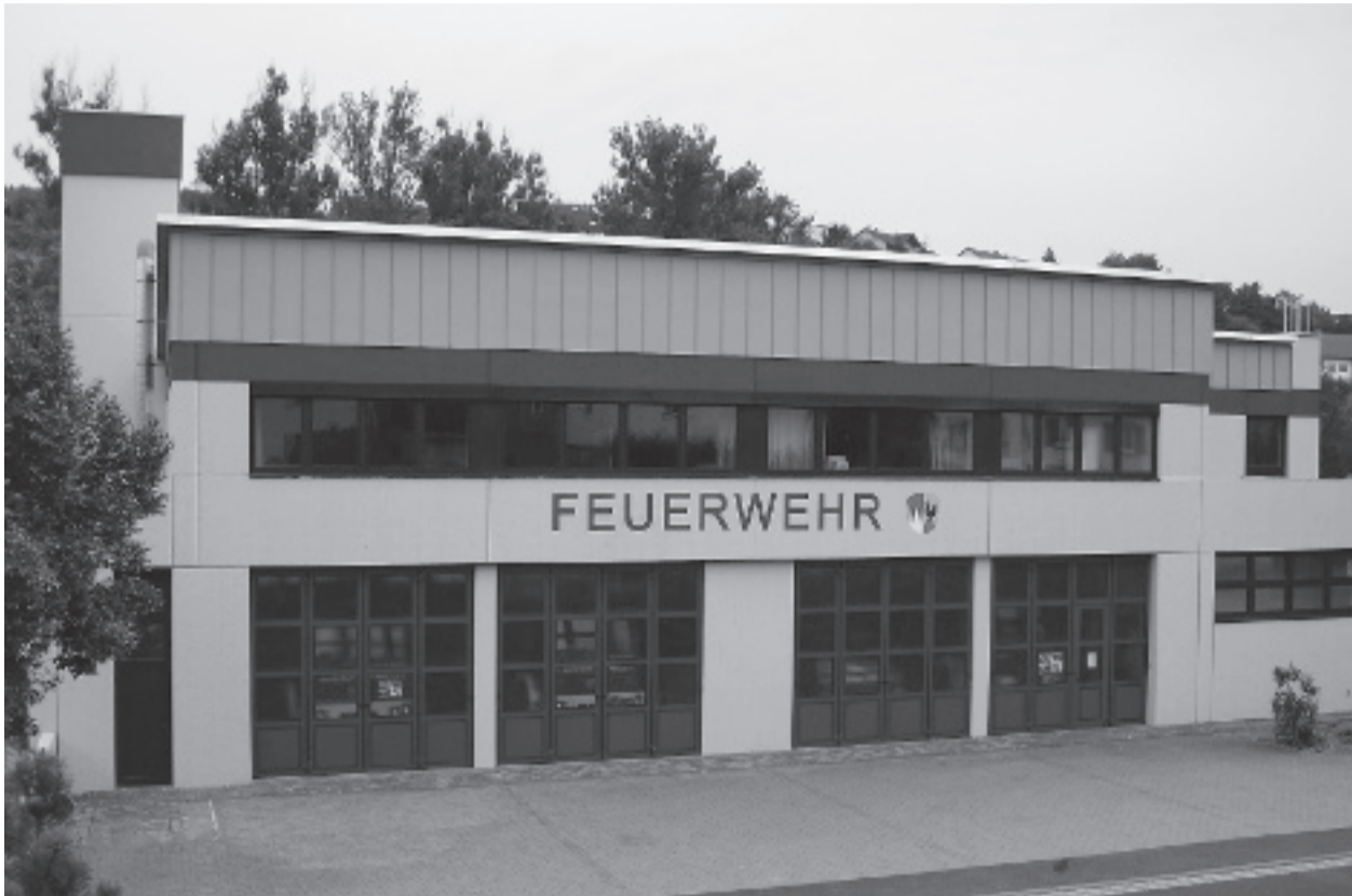
Unser schmuckes Feuerwehrhaus nach Abschluss der Sanierungsarbeiten im Herbst 2006
